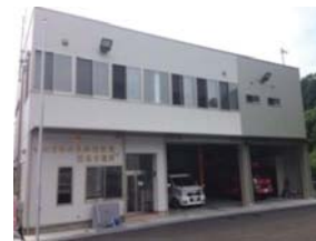
消防庁舎復旧事業 (いわき市消防本部 小名浜消防署江名分遣所)
